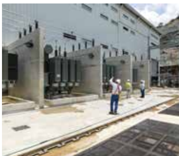
Subestación Oxec II, Transformador 69 kV
