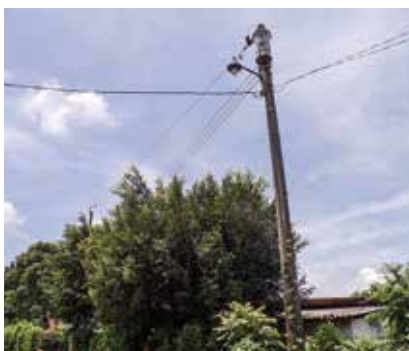
Poste inclinado, invasión vegetación
