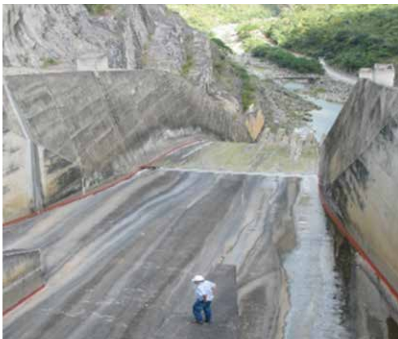
Inspección sobre vertedero, Presa Pueblo Viejo, Chixoy
